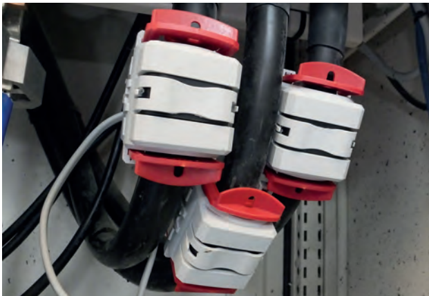
Die Kabelumbauwandler vom Typ KBR eignen sich ideal zum nachträglichen Einbau in bestehende Anlagen
