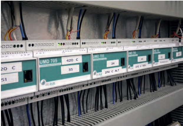
Zur Erfassung des Energieverbrauchs kommen bei MBS die Messgeräte UMD 705 von PQ Plus zum Einsatz
