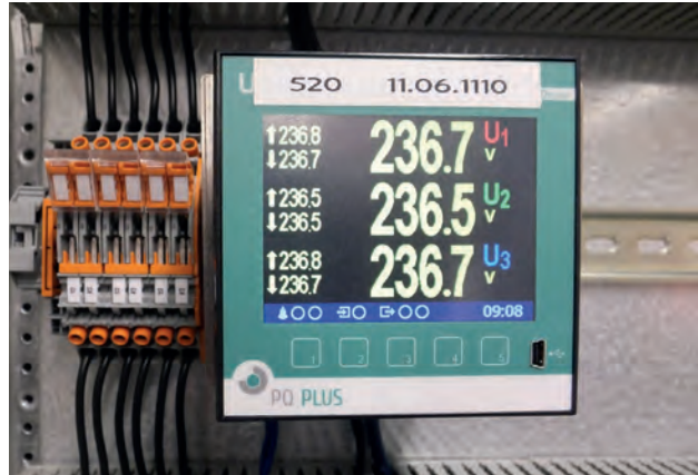
Das UMD 97 wurde speziell für die Überwachung der Energie- und Stromqualität entwickelt
