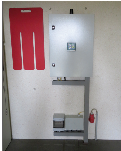
Bild links: In den Ortsnetzstationen sorgt der GridCal Node dafür, dass alle wichtigen Informationen hochauflösend erfasst, sinnvoll verarbeitet, ausgewertet und für den Abruf On-Demand vorgehalten werden Bild rechts: Das GridCal-System in einer begehbaren Ortsnetzstation
